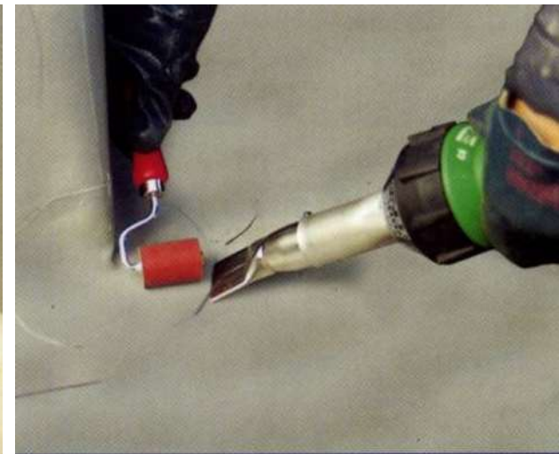
Soldadura per aire calent
