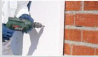
Perforación de la placa por 5 puntos
